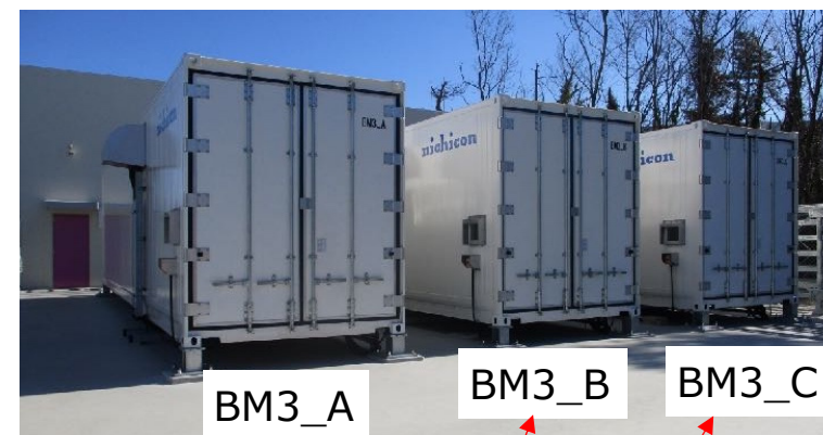
BM3用コンデンサバンク(屋外)
