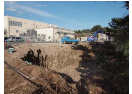
ヘリウム液化機棟の建設工事 ニュートリノ第一設備棟南側
