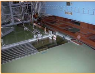
ハドロンスイッチヤード。電磁石へのケーブルピットが浸水。その後、排水。
