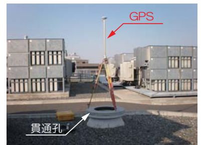
GPS測量作業 (3GeVシンクロトロン屋外電源ヤード)
