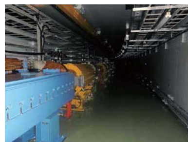
50GeVシンクロトロントンネル内部の加速器装置などに外観上の問題は概ね無し。真空度確認試験等を進めている。
