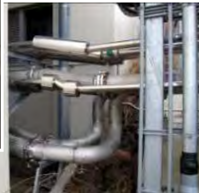
↑ 宙づりになった配管 配管ベロ一部のゆがみ →
