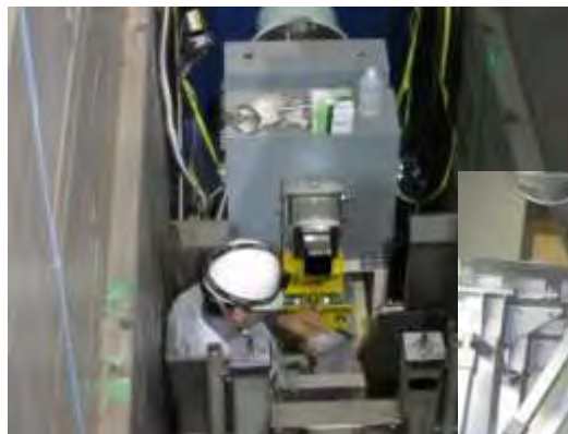
長尺ビームライン → (BL-08)のガイド管が、一部破損。破損部付近の鉄遮蔽体撤去作業。
