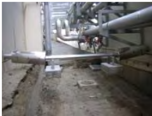
↑ 宙づりになった配管 配管ベロ一部のゆがみ →
