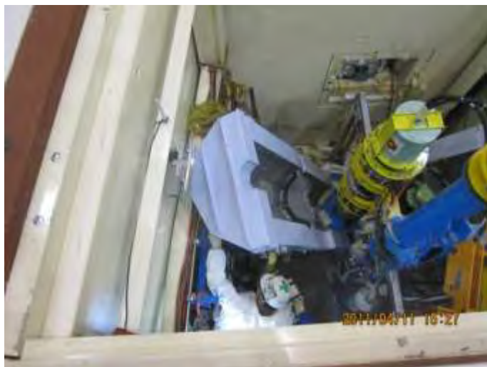
↑ 本体遮蔽体天井部解体後、内部で転倒した鉛遮蔽体の取り出し作業。
