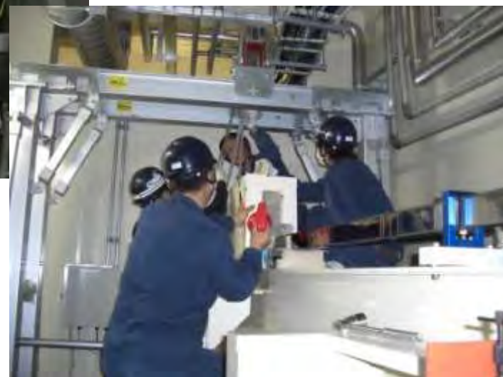
← ガイド管ミラー確認作業。
