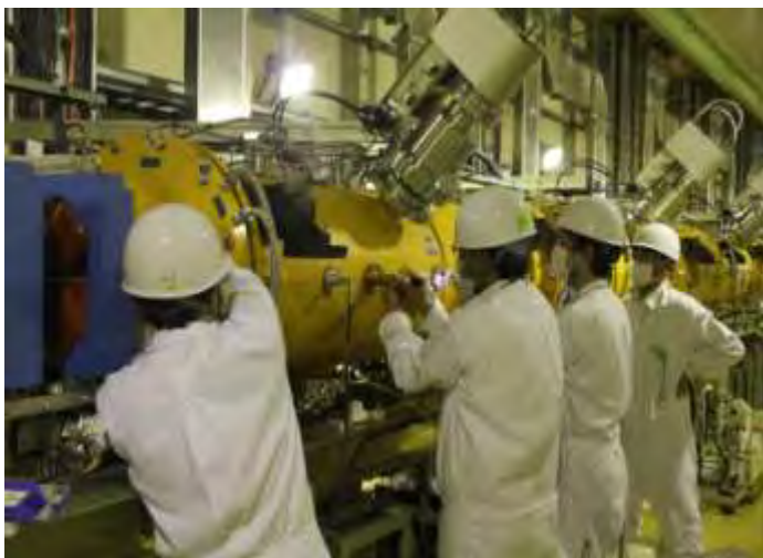
← 空洞内撮影 作業の様子
