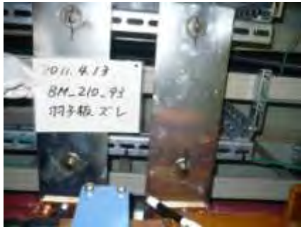
↑ 端子板(通称;羽子板)のずれ
