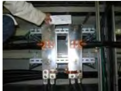
↑ 端子板(通称;羽子板)のずれ
