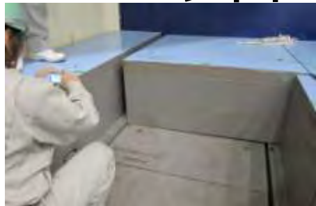
↑ 前置き遮蔽体のズレ確認、解体開始 →
