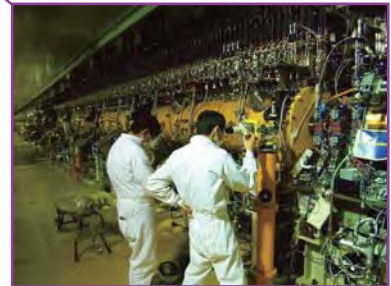
DTLに装着されているドリフトチューブの変位量確認作業
