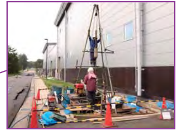
リニアック棟廻り地盤のボーリング調査
