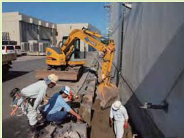
建屋周りの地盤沈下の復旧工事。
