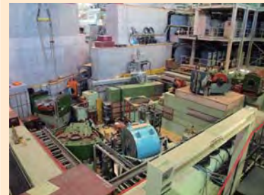
ハドロン施設北側実験ホールでは、K1.8 ビームラインの機器の再据付けを開始。
