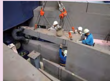
MLF 前置き遮蔽体は、全ブロックにスレ防止治具を取付けて再度設置のやり直し。
