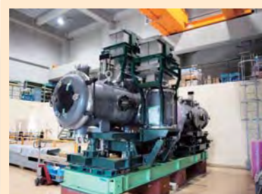
K1.8 二次ビームラインの第2静電セパレータを取り外して装置全体の総点検を実施。
