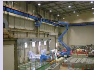
リニアック地上建屋では、高所作業車を持ち込んでクレーンのランウェイガータ(走行レール)の点検・修復工事を実施。
