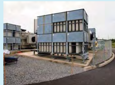
3GeV シンクロトロン屋外ヤードの傾斜したトランスなどは、コンクリート台座や支柱の嵩上げにより元の状態に復旧。
