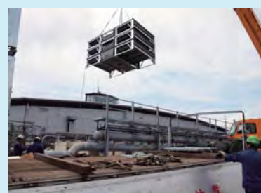
3GeV シンクロトロン屋外ヤードの冷却水設備、被災した冷却塔は全て新品と交換。
