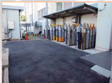
ハドロン実験施設、建家周辺の陥没部は復旧がほぼ終了。
