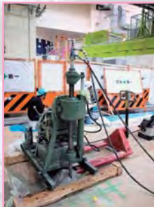
約15cm沈下したMLF西側増設建家全体をジャッキアップしながら、床下へコンクリートを注入。
