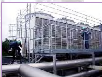
リニアック装置冷却系屋外冷却塔、高圧水による洗浄作業を実施。
