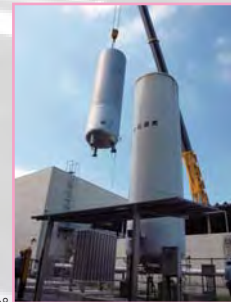
傾いたヘリウムバッファタンクは一旦撤去。地盤、コンクリート基礎を修復しタンクを再度設置。
