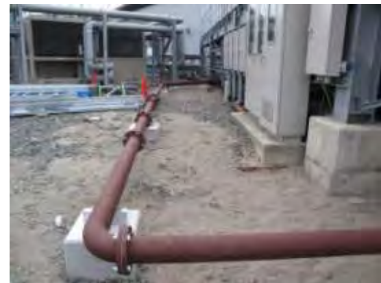
仮設配管を設置し、給水可能
