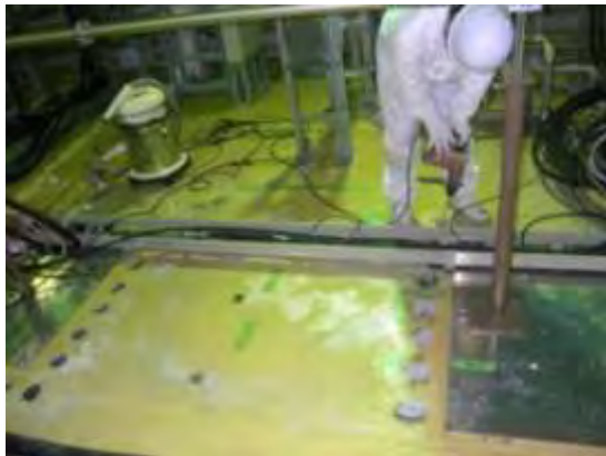
トンネル部の止水工事作業。右は修復完了状態
