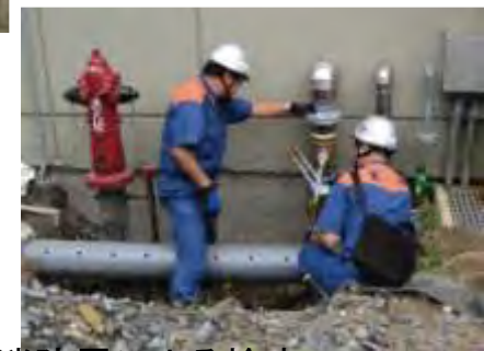
消防署による検査
