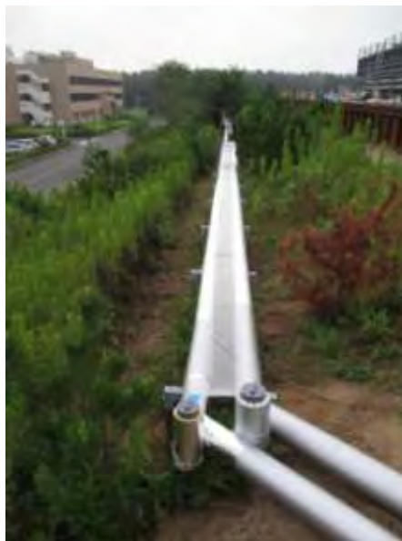
仮設配管を設置し、給水可能
