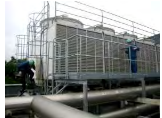
高圧水による冷却塔洗浄作業
