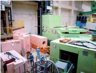
物質・生命科学実験施設のミュオン実験施設では、第2実験ホールに超低速ミュオン実験装置の建設を開始。
