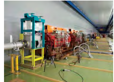
ハドロン実験施設のスイッチヤードでは、電磁石のアライメントが進められている。
