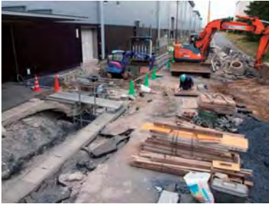
リニア棟玄関前の道路、及び周辺陥没部の復旧工事を開始し、11月中旬に復旧の予定。
