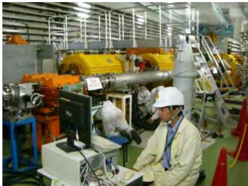
レーザートラッカーを使用した、電磁石のアライメント作業。
