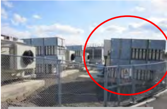
震災直後：機器の基礎が傾く
