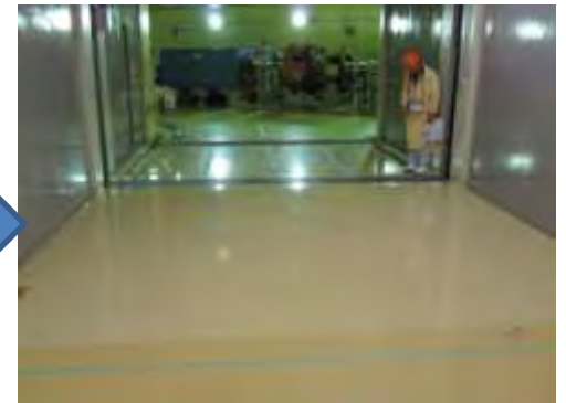
トンネル搬入通路の段差補正作業終了
