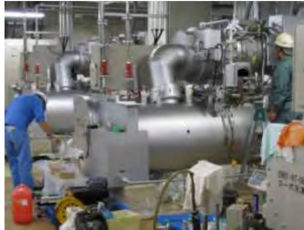
←空調用ターボ冷凍機の点検作業。一部に不具合があり、修理作業を実施。
