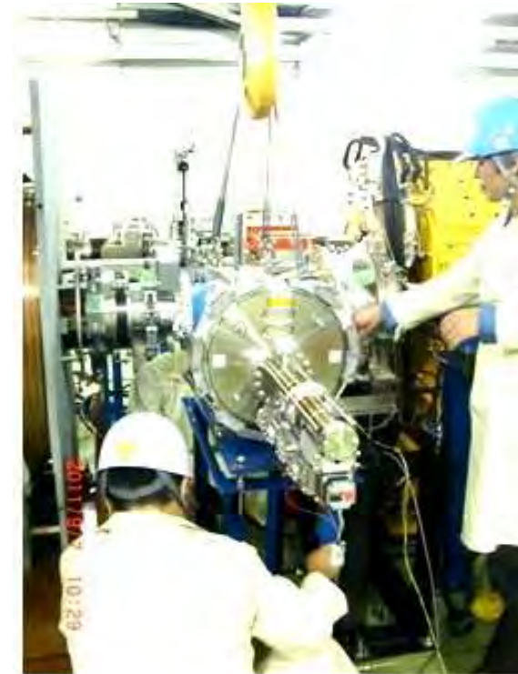
モニタ、真空関係機器の復旧作業
