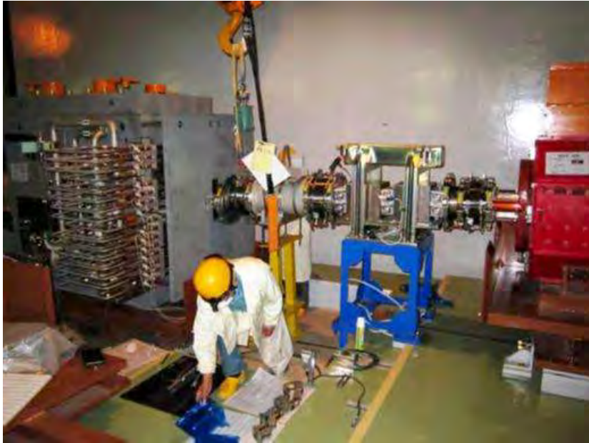
スイッチヤードでのアライメント作業
