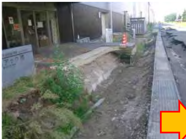
リニアック棟玄関前陥没部の復旧状況
