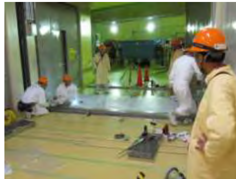
トンネル搬入通路の段差補正作業終了
