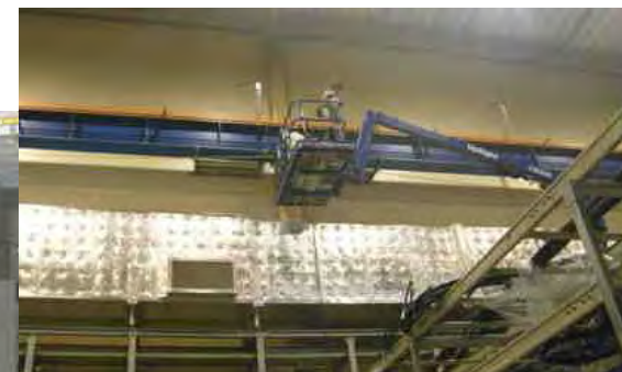
クレーン、照明等の復旧作業
