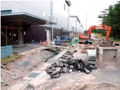
リアック棟玄関前の給排水管復旧工事(11月末完了予定)。
