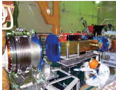
3GeV シンクロトロン入射部機器の調整。
