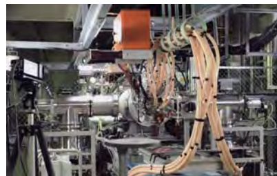
復旧作業が終了したイオン源
