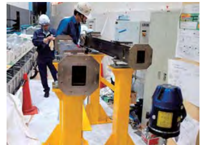
物質・生命科学実験施設では、BL02 中性子ビームラインのガイド管設置作業を継続実施。
