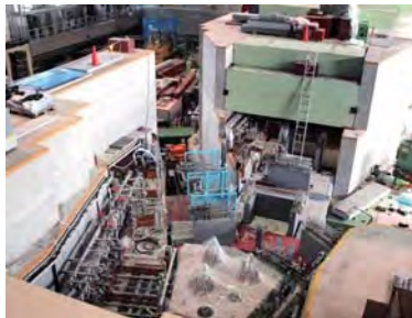
ハドロン実験施設では、電磁石等機器や遮蔽体の再設置を進めている。
