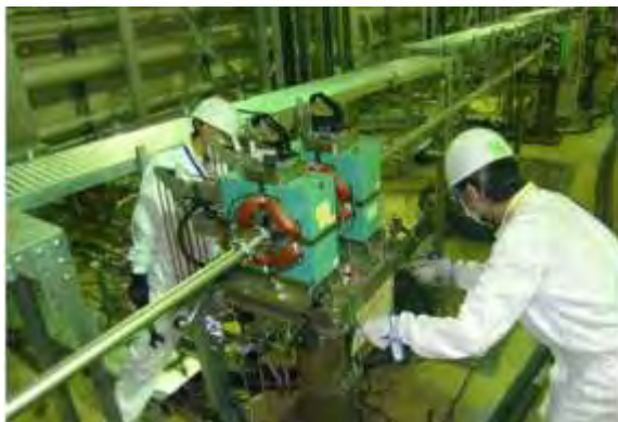
L3BT電磁石アライメント作業
