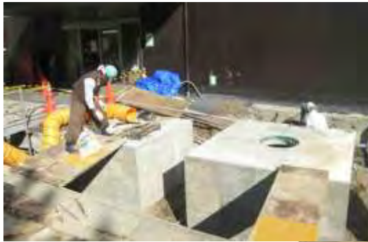
排水枡(上)、工水配管(右)の復旧作業
