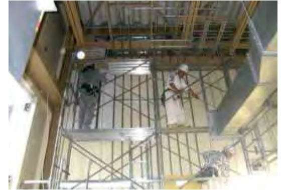
間仕切り壁の復旧作業
