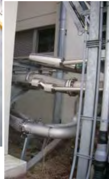
↑ 冷却水配管の 歪み修正工事に 着手
