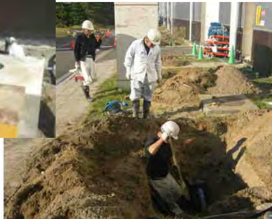
排水枡(上)、工水配管(右)の復旧作業
