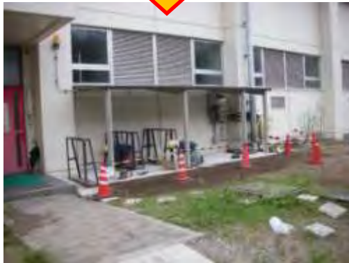
ポンベスタンド付近の 復旧工事完了
