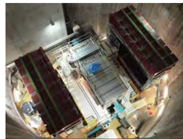
前置検出器の点検・調整 (ニュートリノ実験施設)
