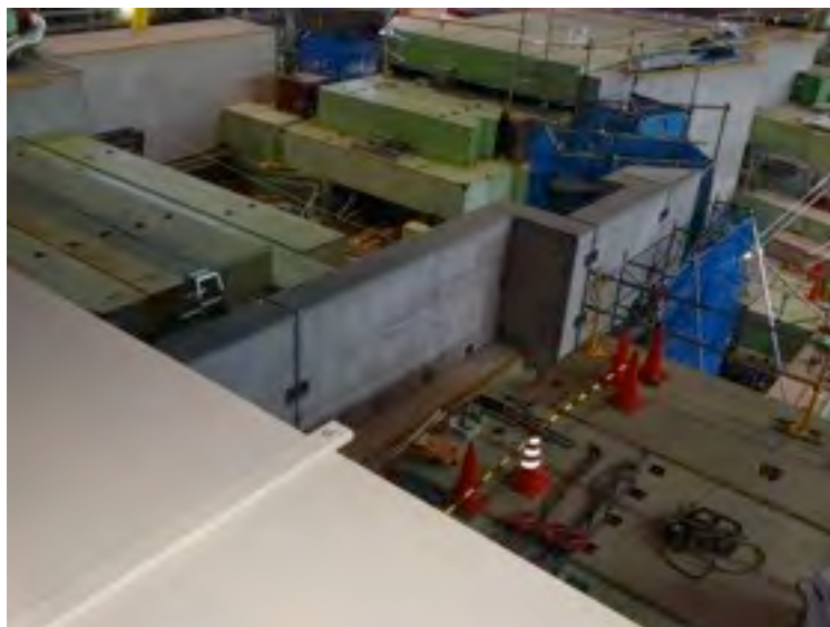
南側の開口部（作業中）
