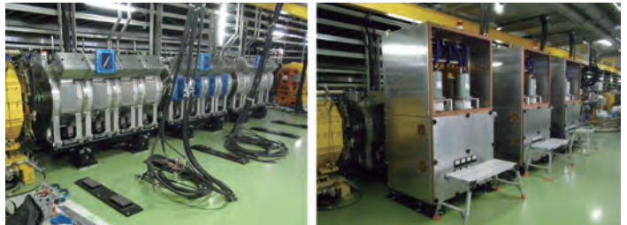
より速いサイクルで動く新電源システムのため新規開発された、(左)コンデンサバンクと(右)コンデンサユニットです。
