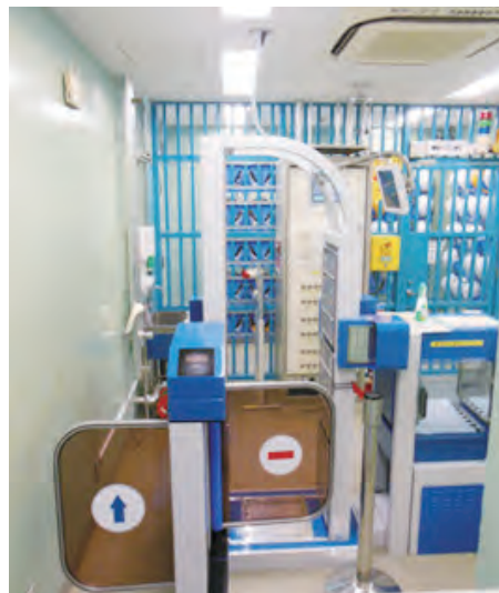
放射線管理区域へ入退域するためのゲートシステム
