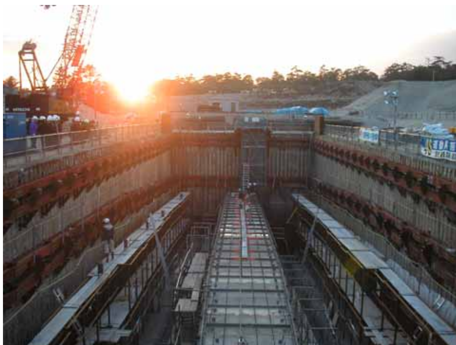
ニュートリノディケイボリウム工事現場(2005年3月1日、日没時)
