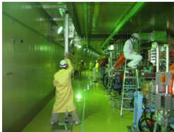
3NBTトンネル内での 測量作業の様子
