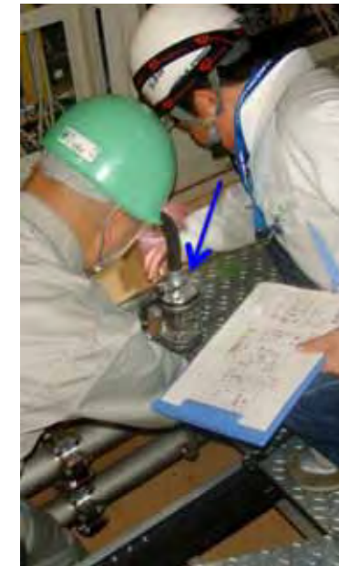
通水試験の様子。矢印部が増し締めした所
