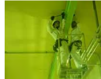
リニアック加速器トンネル 天井クレーンレールの点検
