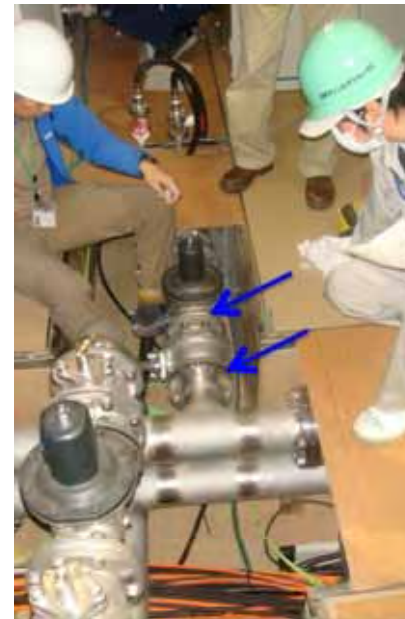
通水試験の様子。矢印部が増し締めした所
