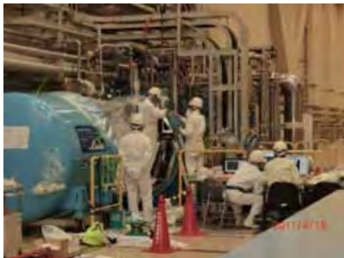
膨張タービンの 点検の様子
