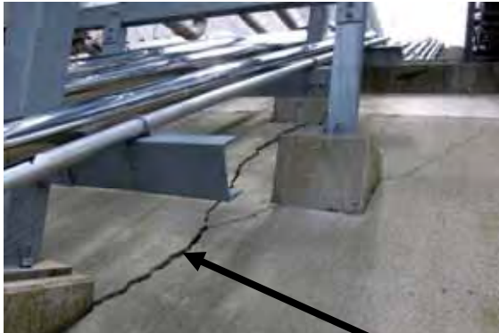
冷却水斜面配管部コンクリート基礎の割れ
