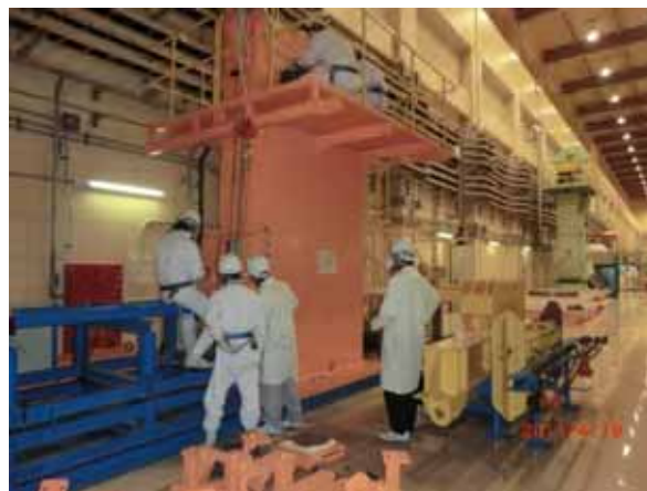
シャッターブロックの 吊り上げと、大型機 器取扱作業室での 点検の様子
