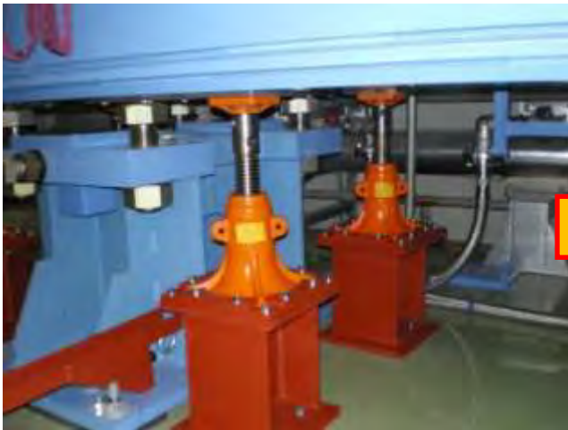
電磁石のジャッキアップ(架台との切り離し)
