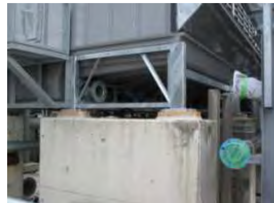
冷却塔の設置枠を補強して、設置作業完了。左はポンプ、モーターの精密調整作業
