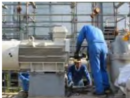
冷却塔の設置枠を補強して、設置作業完了。左はポンプ、モーターの精密調整作業
