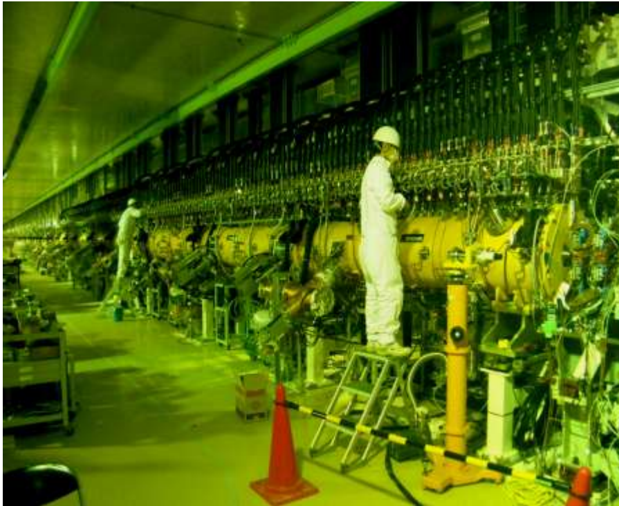
アライメント終了後の加速空洞は、通水試験を実施。順調に復旧が進む。
