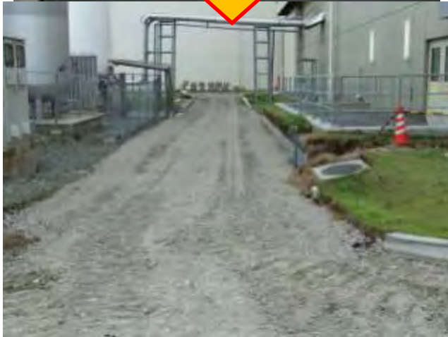
約1.5m沈下した路盤を復旧
