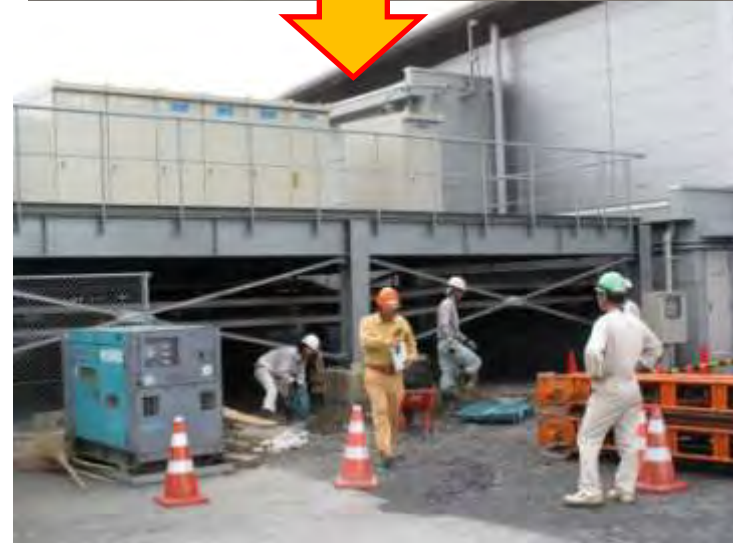
電源盤架台全体のジャッキアップ作業完了
