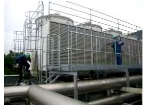
高圧水による冷却塔洗浄作業
