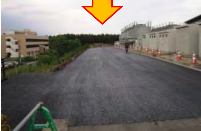
沈下により波打つ道路を復旧
