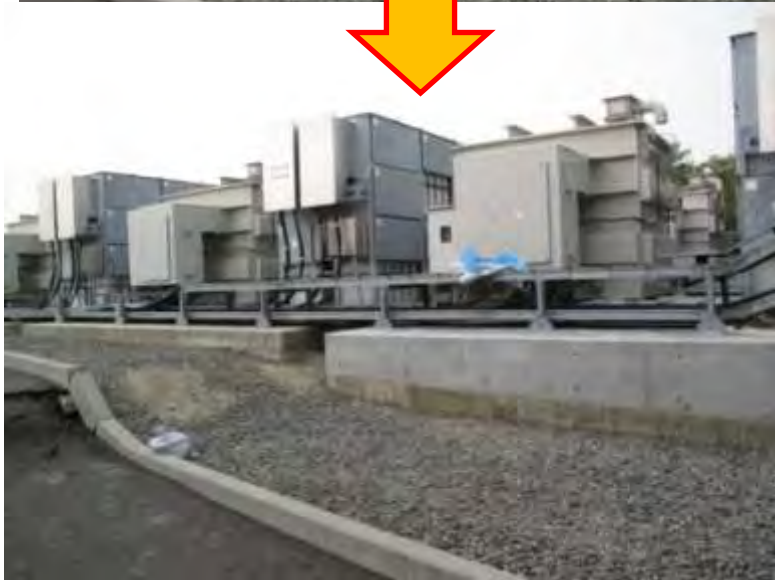
変圧器、コンデンサ等の嵩上げ作業完了
