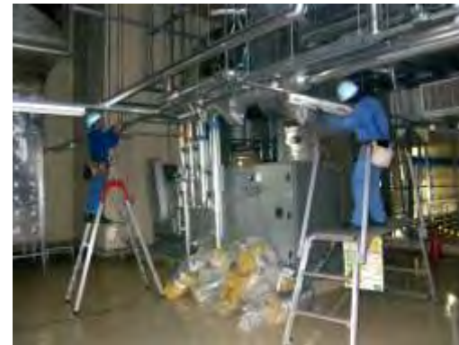
電源設備復旧作業
