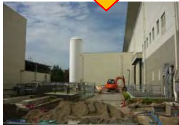
傾いた液体Heタンクを取り外して一次待避させ、基礎修復後に再設置する
