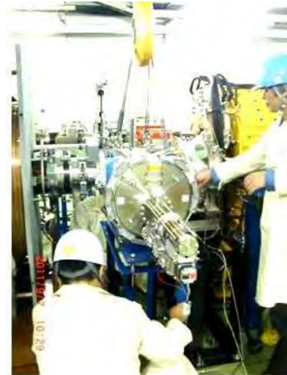
モニタ、真空関係機器の復旧作業
