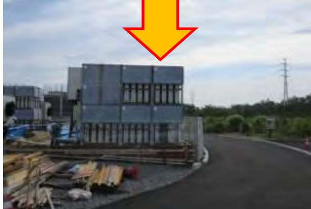
電源ヤード機器の基礎補修や沈下部の嵩上げ作業が完了。
