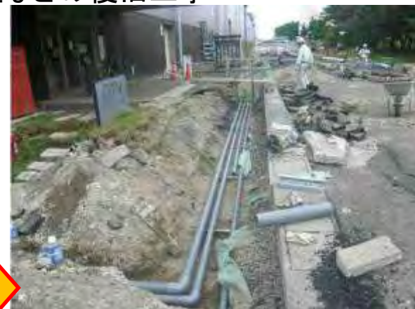
給排水配管や消火栓などの復旧工事
