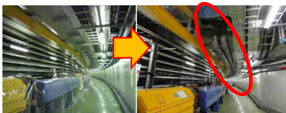
RF冷却配管を支持金物に取り付け
