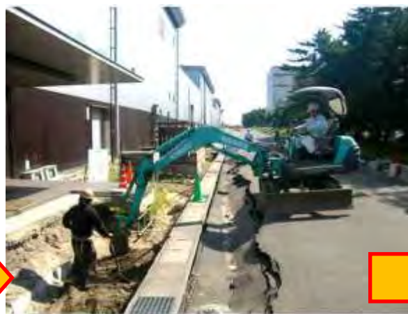
給排水配管や消火栓などの復旧工事
