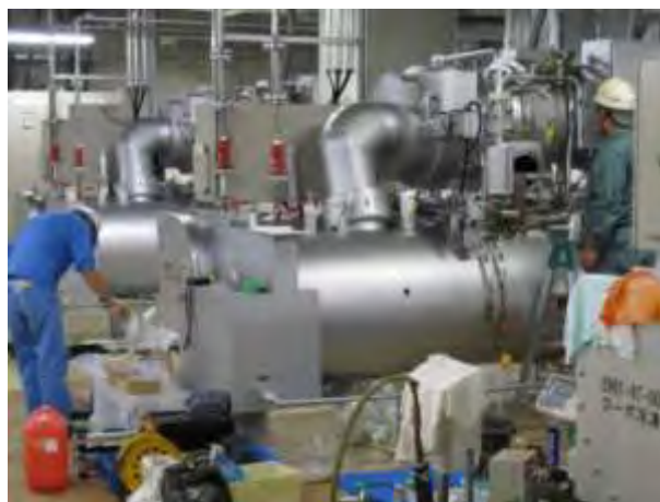
←空調用ターボ冷凍機の点検作業。一部に不具合があり、修理作業を実施。
