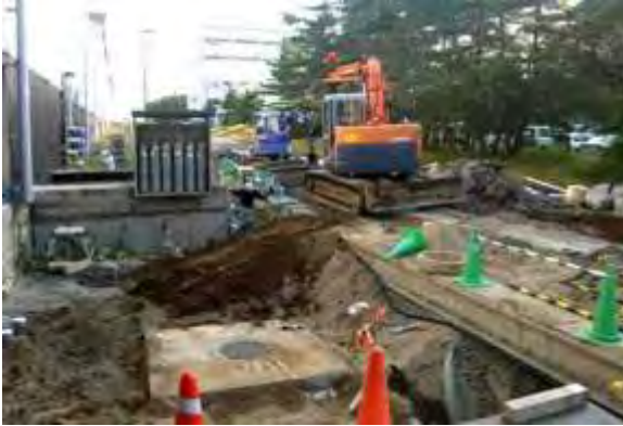
道路、給排水配、排水枡などの復旧工事
