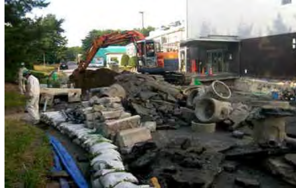
道路、給排水配、排水枡などの復旧工事
