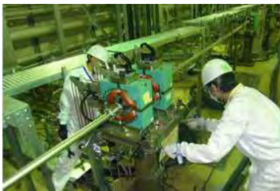
L3BT電磁石アライメント作業
