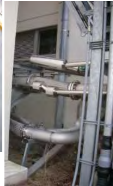
↑ 冷却水配管の 歪み修正工事に 着手
