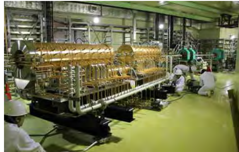
ACSを加速器トンネル内に搬入
