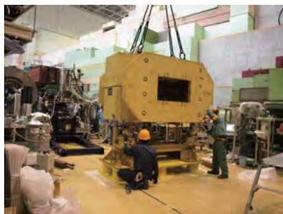
K1.8BRへの電磁石(牛若)の設置 (ハドロン実験施設 / 実験ホール北側)
