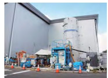
リニアック棟南側に設置されたセメントミキシング設備
