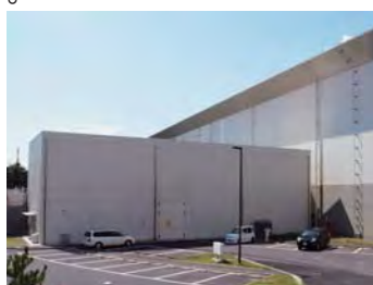
革新型蓄電池実験棟
