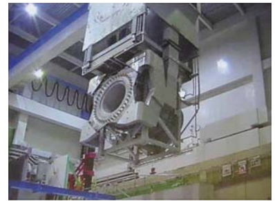
第3電磁ホーンの取出し (11月26日)
