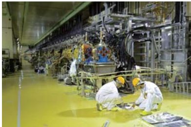
加速器初段部の入れ替え作業 (リニアック)
