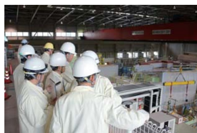
施設改修工事状況の視察 (ハドロン実験施設)
