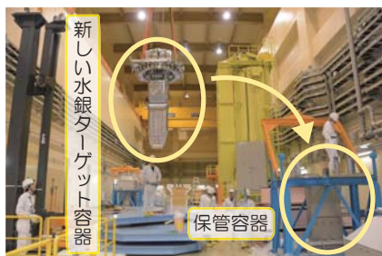
新しい水銀ターゲット容器 保管容器 大型機器取扱室での作業の様子 (MLF)
