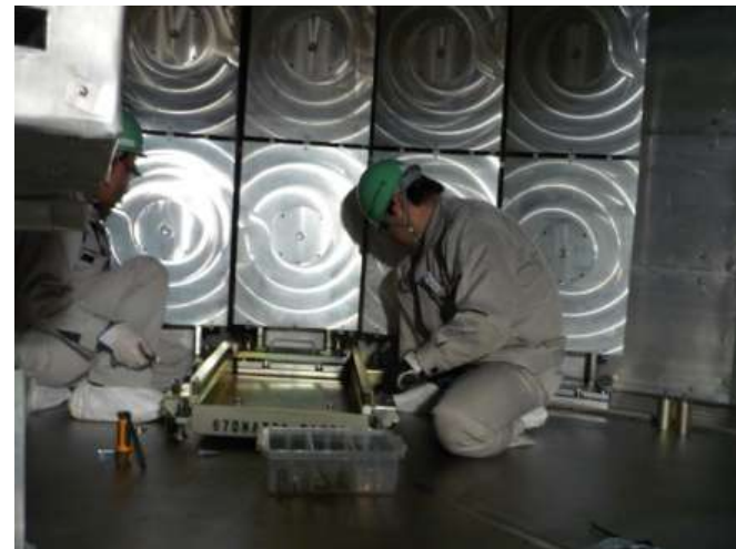
真空タンク中
