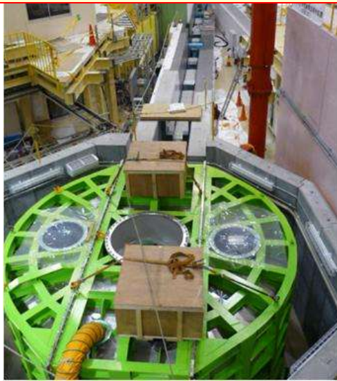
真空タンク合体完了 :2011.10
