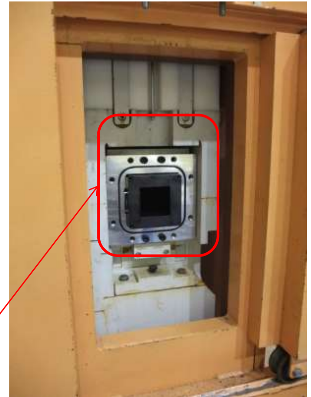
ビームシャッター (25t) 2本のロッドのつりさげ構造
