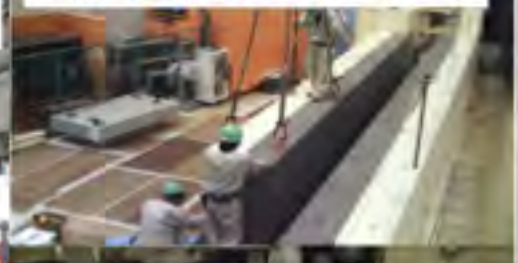
壁際遮蔽体解体
