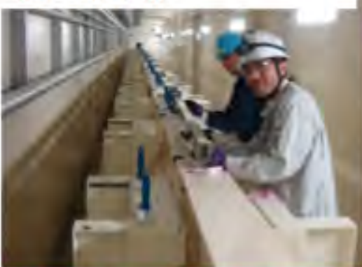
下流ガイド管撤去・清掃・修理等作業
