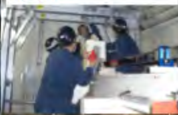
壁際遮蔽体撤去・修復
