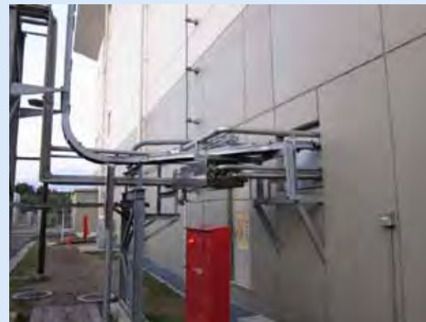
復旧後の写真
