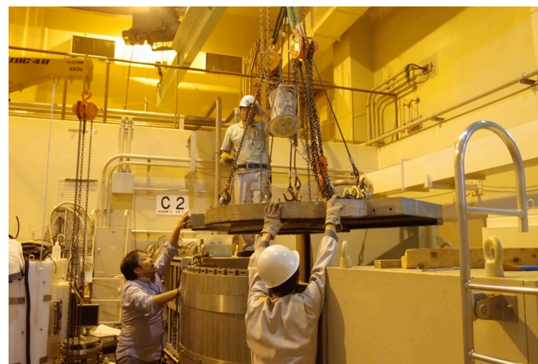
LTAS撤去作業
