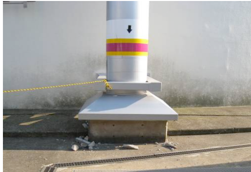
排気ダクトの損傷
