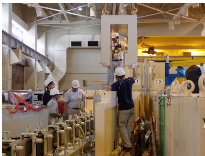
T1遮蔽体撤去作業
